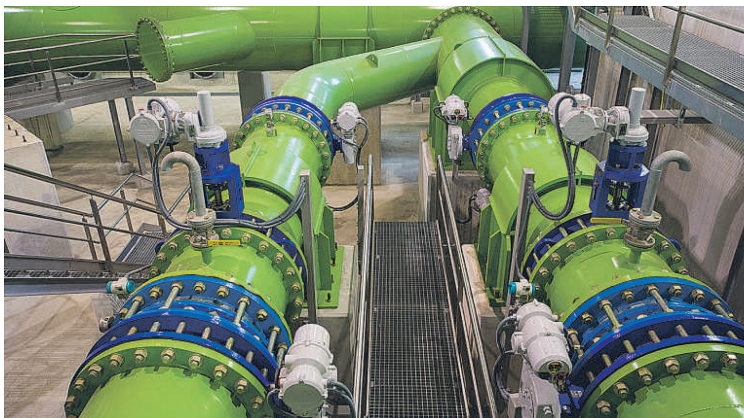
Interior de la estación de bombeo de Font Santa, una instalación imprescindible para la interconexión de la red de ATLL
